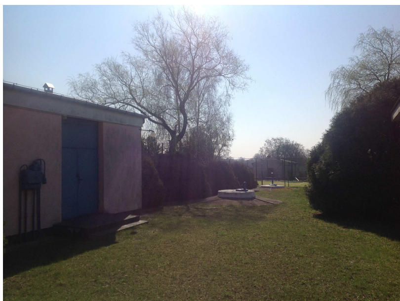
Zdj.1 Ujęcie wody
