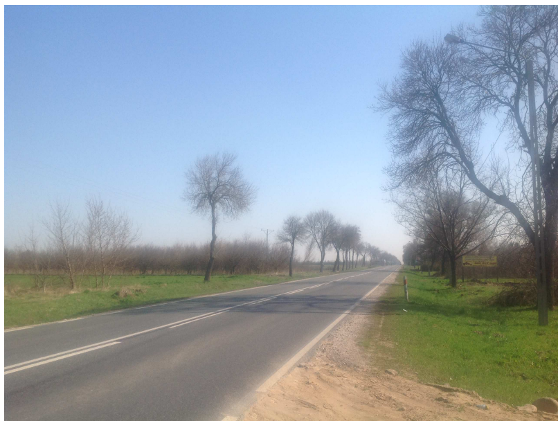
Zdj.4 Droga krajowa 62
