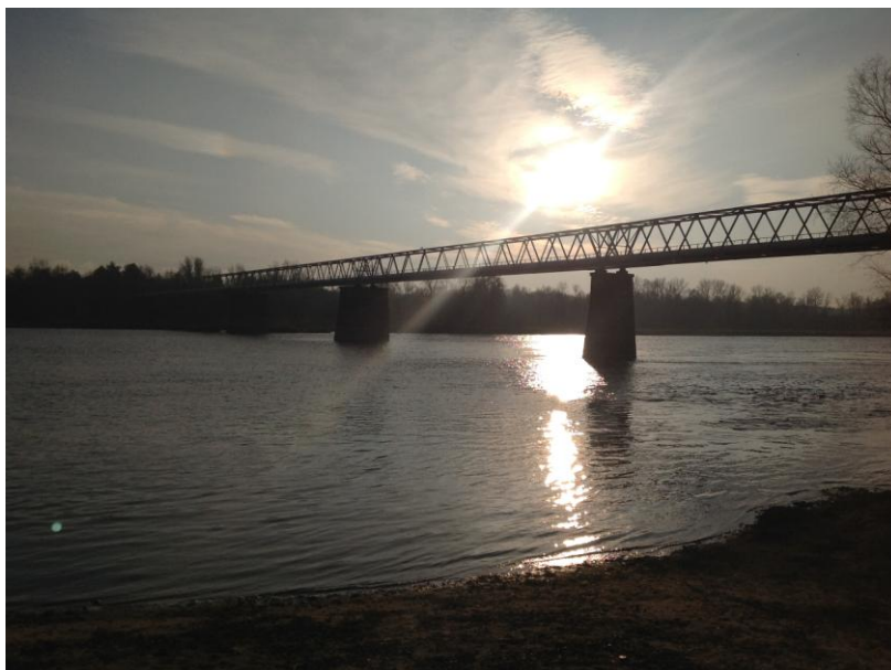
Zdj.3 Ropociąg na rzece Narew
