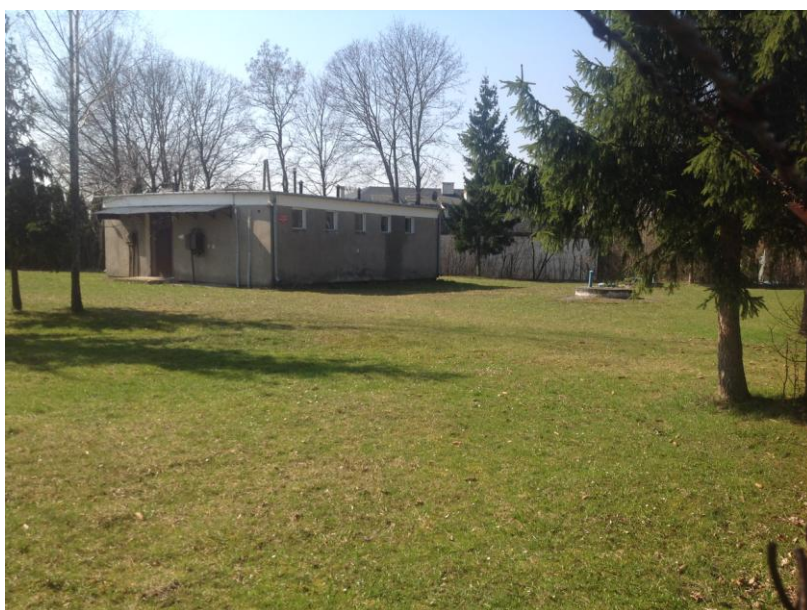
Zdj.2 Ujęcie wody w Starym Orzechowie
