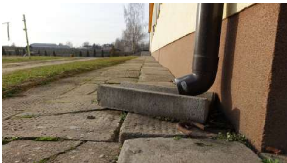
Koryto betonowe odprowadza wody z rury spustowej na elewację, podczas kiedy kierunek odpływu powinien być odwrotny
