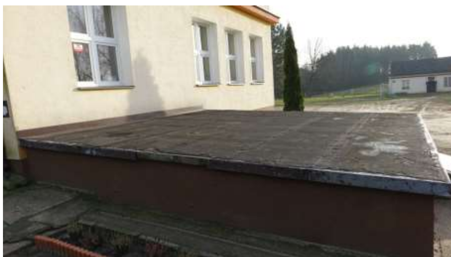
W kolejnych etapach prac należy przewidzieć wymianę pokrycia z papy na nową
