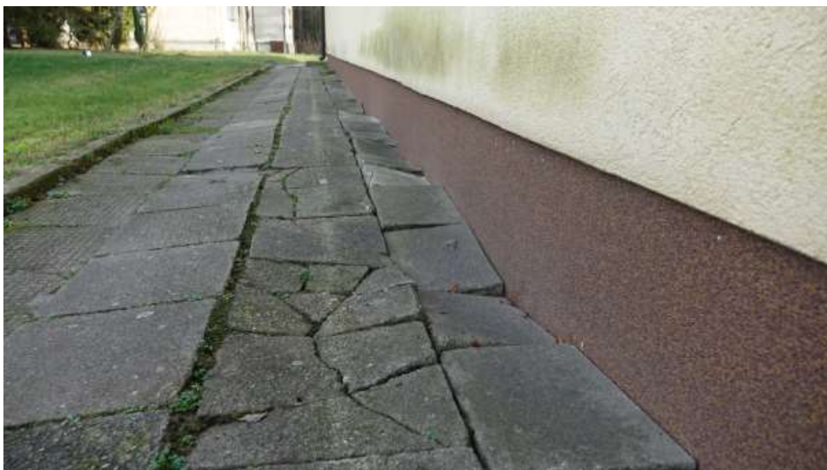
Destrukcja opaski – zapadające się płyty chodnikowe
