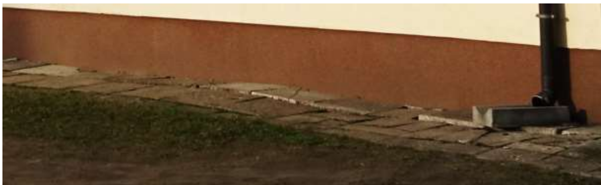
Destrukcja opaski przy elewacji południowej budynku. Wynika to z niewłaściwie zagęszczonego gruntu pod opaską.
