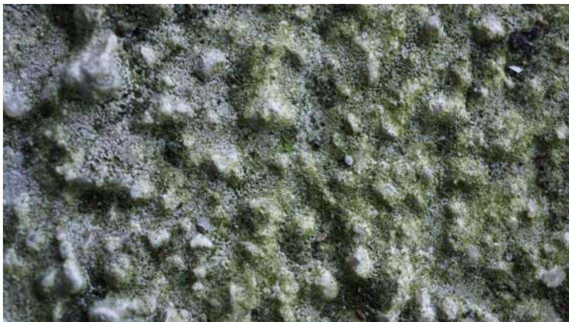
Powierzchnia elewacji jest porowata, jest to tzw. „baranek”. Elewacja z taką fakturą wymaga szczególnej ochrony i zabezpieczeń
