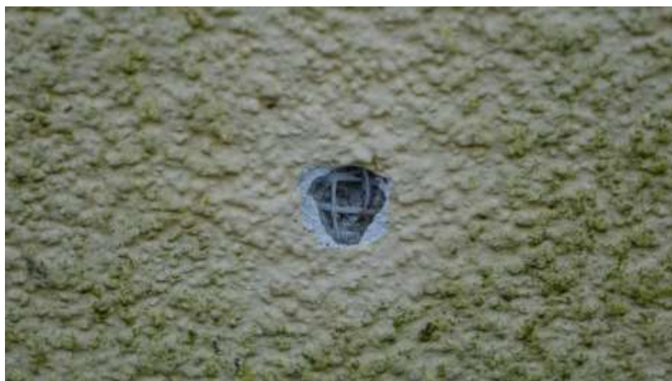
Pod tynkiem znajduje się docieplenie i siatka na kleju
