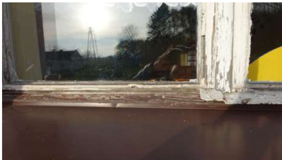
Drewniana stolarka ulega stopniowej destrukcji
