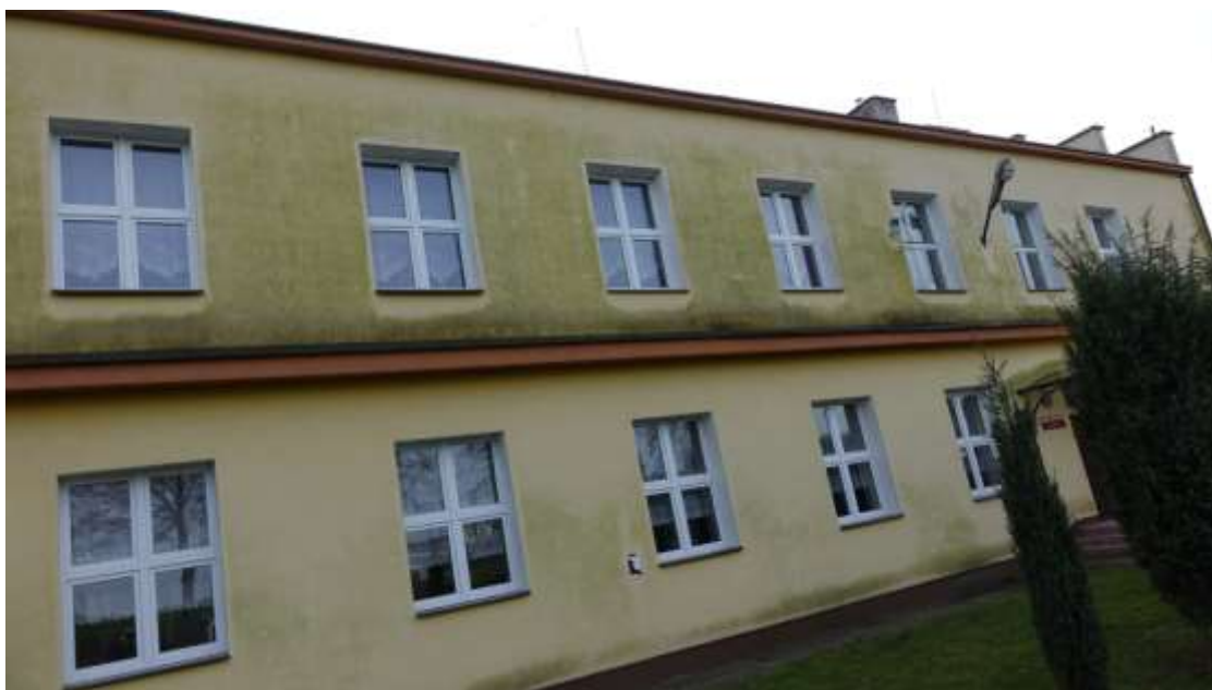
Widok ogólny na elewację i skażenie glonami oraz grzybami pleśniowymi
