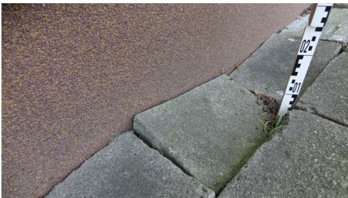
Znaczna ilość i wielkość zapadlisk, spowodowanych nieprawidłowym zagęszczeniem gruntu.
