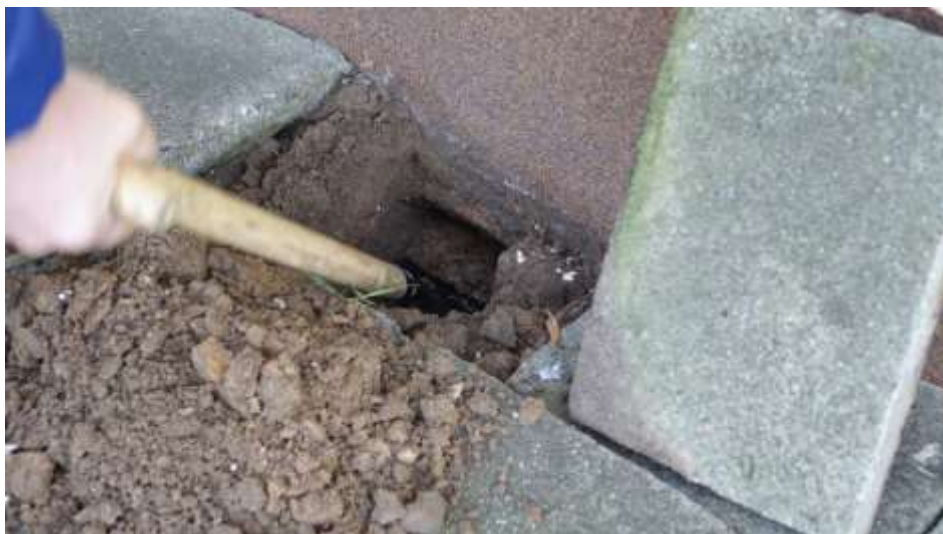
Wykonano odkrywkę celem zbadania docieplenia, znajdującego się w strefie pod poziomem terenu
