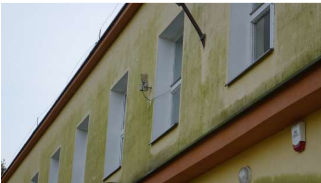
Pleśnie i glony, porastające elewację - druga kondygnacja
