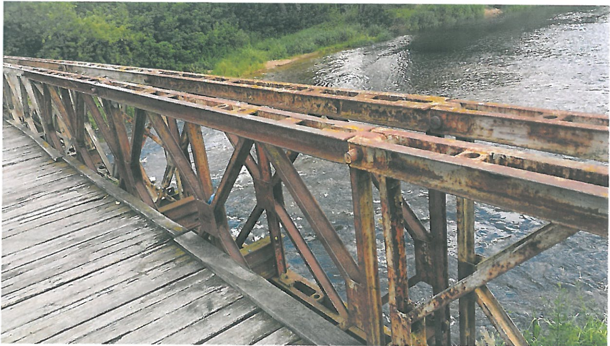
↑ Istniejące połączenie elementów konstrukcyjnych krat.
