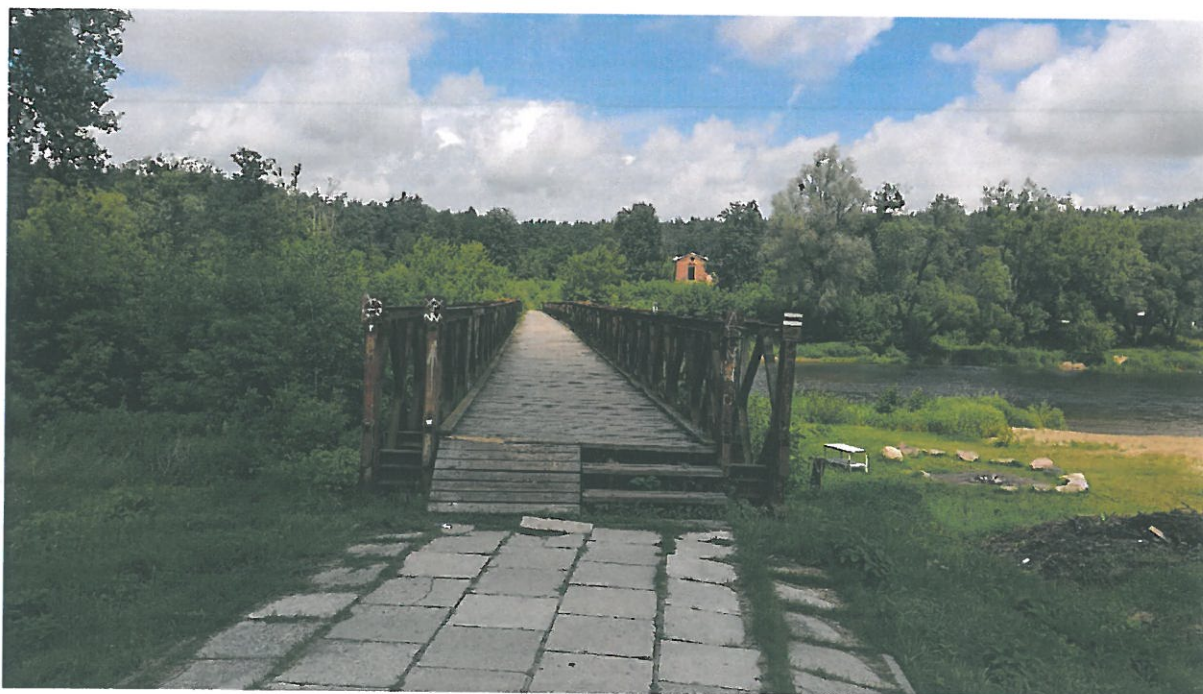
↑ Istniejące dojście do obiektu
