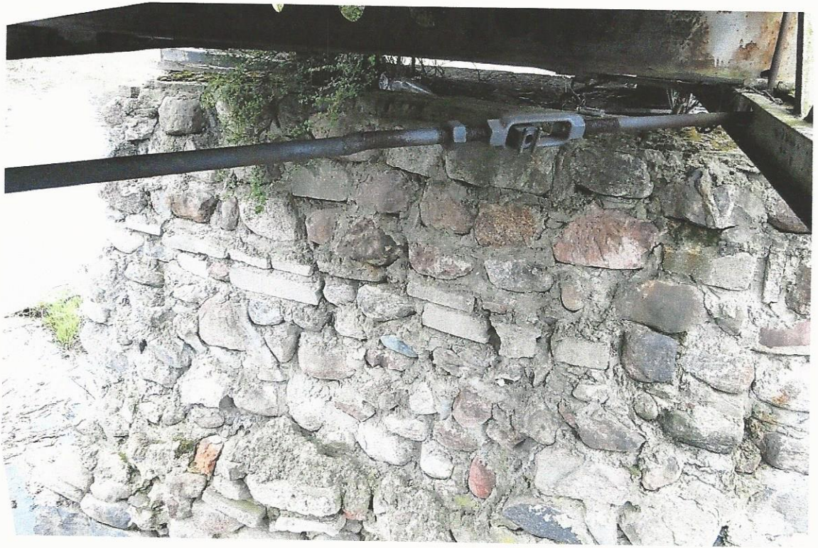
Fot. 4.17 Południowa część podpory nr 3. Również po tej stronie widoczna jest skośna rysa biegnąca od górnej płaszczyzny filara do krawędzi po stronie górnej wody
