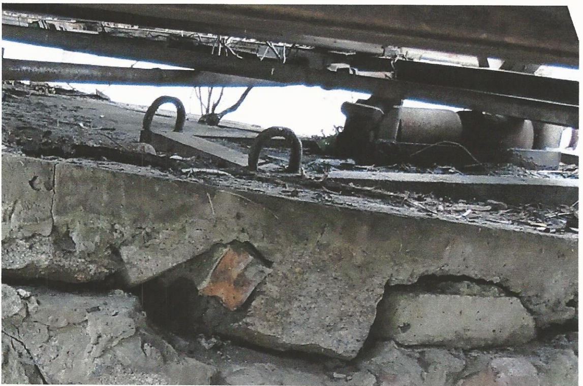
Fot. 4.12 Zapadnięcie łożyska na podporze nr 4.
