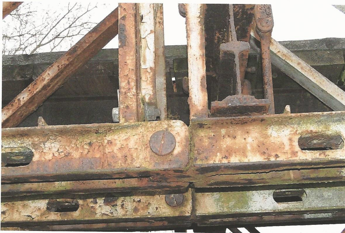
Fot. 4.9 Dolna powierzchnia kraty. Ubytki powłok od 60 do 100%. Korozja na całej powierzchni elementów. Brak uszkodzeń mechanicznych. Ubytki korozyjne bez wpływu na nośność kraty. Niewielki luz wokół sworzni.
