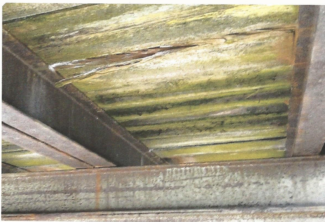
Fot. 4.3 Wegetacja porostów na spodzie pokładu kładki. Odłamane krawędzie bali. Całkowite zniszczenie powłok i korozja powierzchniowa poprzecznie i podłużnie.
