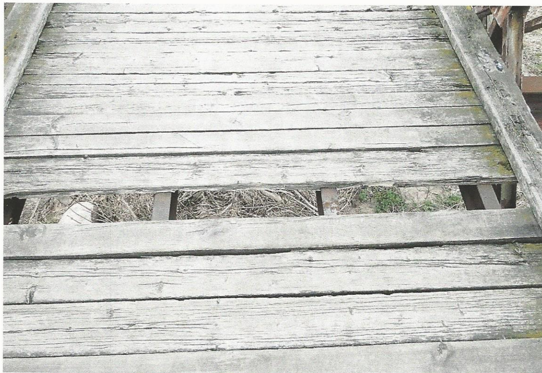
Fot. 4.2 Butwiejące deski. Ubytek pokładu szerokości jednej deski.
