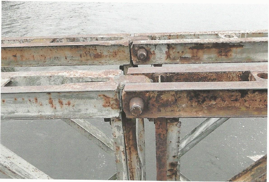
Fot. 4.5 Połączenie elementów konstrukcyjnych kraty. Ubytki powłok od 60 do 100%. Korozja na całej powierzchni elementów. Brak uszkodzeń mechanicznych. Małe luzy między trzpieniem a otworami łączącymi.
