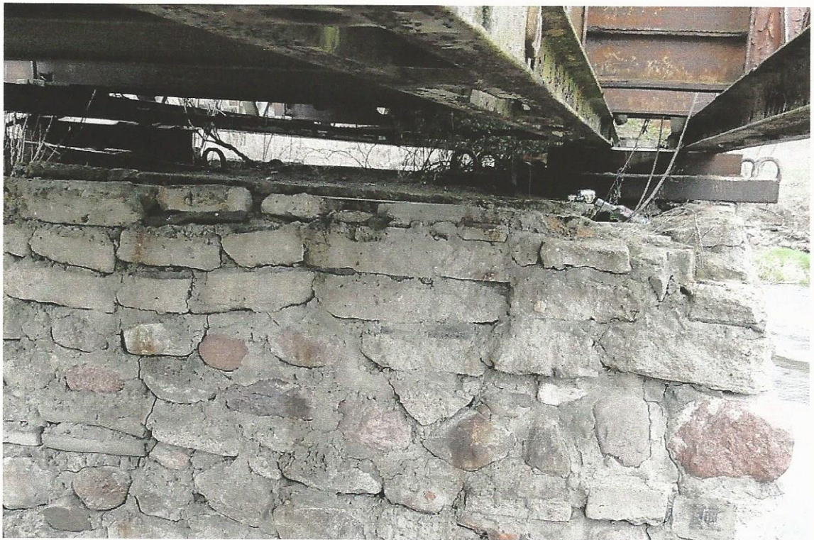
Fot. 4.11 Przekrzywione łożyska na podporze nr 3. Łożysko wystaje poza obrys podpory.
