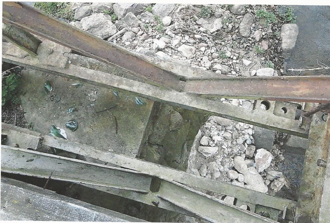
Fot. 4.21. Podpora nr 4. Pogorszenie warunków podparcia kładki wskutek powstania wyrwy w konstrukcji filara.
