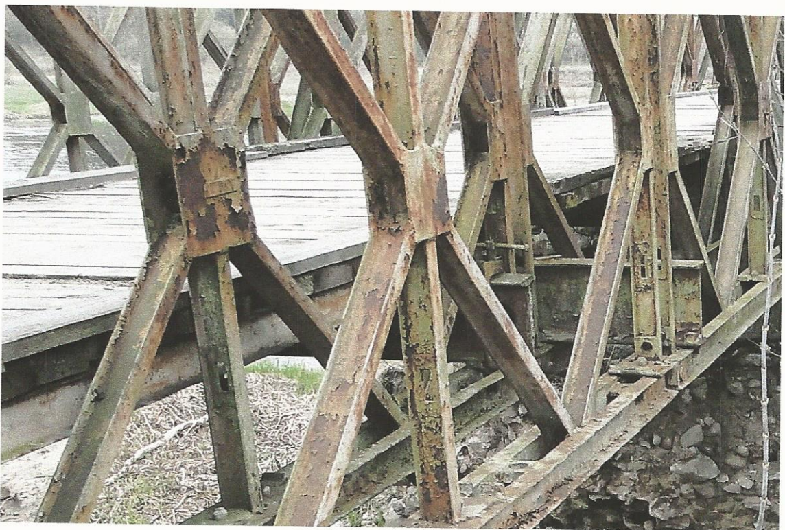
Fot. 4.6 Środkowy element kraty. Ubytki powłok od 60 do 100%. Korozja na całej powierzchni elementów. Brak uszkodzeń mechanicznych.
