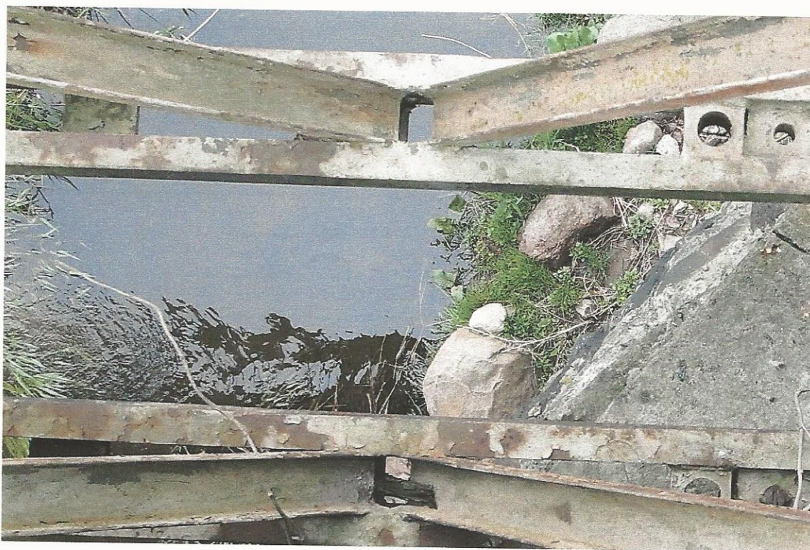
Fot. 4.8 Dolna powierzchnia kraty. Ubytki powłok od 60 do 100%. Korozja na całej powierzchni elementów. Brak uszkodzeń mechanicznych.
