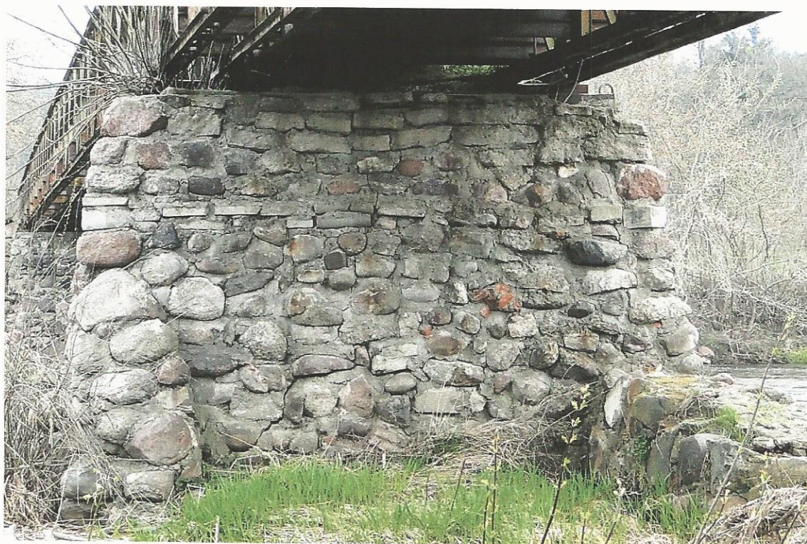
Fot. 4.16 Skośna rysa w podporze nr 3 świadcząca o niebezpiecznym, nierównomiernym osiadaniu fundamentów podpory. W górnej części obiektu widoczna współczesna nadbudowa, również pęknięta.
