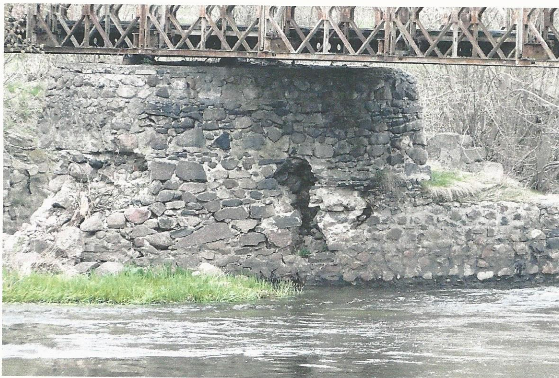
Fot. 4.19. Podpora nr 4, strona północna. Wyrwa w centralnej części podpory oraz widoczna część ubytku po stronie GW.
