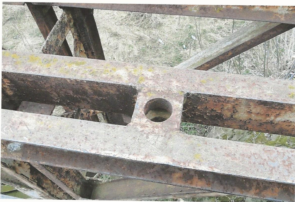
Fot. 4.7 Górna powierzchnia kratownicy. Ubytki powłok do 100%. Korozja na całej powierzchni elementów. Brak uszkodzeń mechanicznych..
