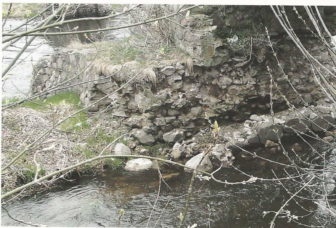
Fot. 4.20. Podpora nr 4, strona południowa. Głęboka wyrwa dolnej części podpory.
