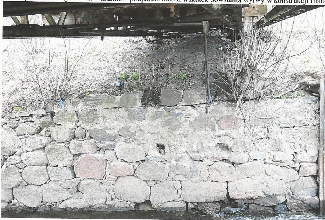
Fot. 4.33. Niepokojący stan ogólny muru oporowego przy podporze 5.
