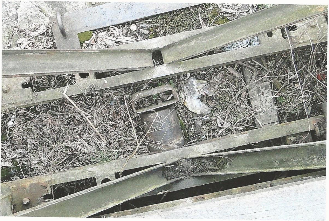
Fot. 4.13 Zapadnięcie łożyska na podporze nr 4.
