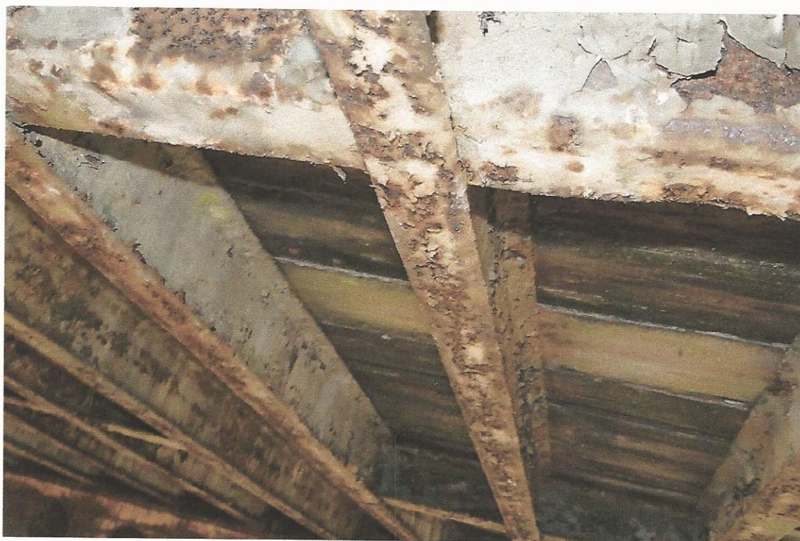
Fot. 4.4. Daleko posunięta korozja podłużnic i poprzecznic.
