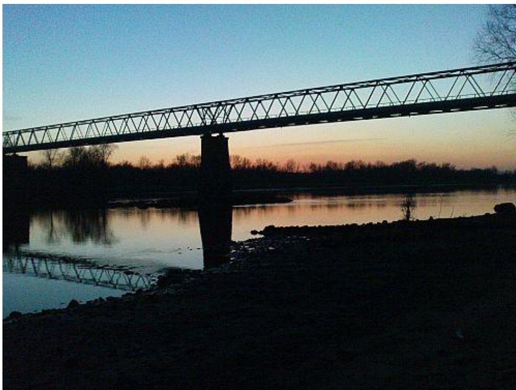
Most w Starym Orzechowie – autor zdjęcia Marcin Gągolewski
