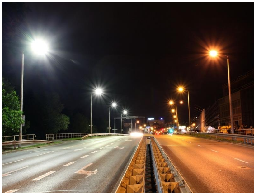
Rysunek 11. Miejskie oświetlenie nocne: porównanie tradycyjnych lamp sodowych (prawa strona zdjęcia) i nowoczesnego oświetlenia opartego o lampy LED (lewa strona zdjęcia)
