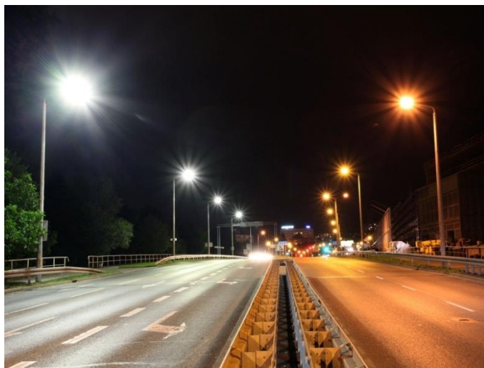
Rys. 12. Miejskie oświetlenie nocne: porównanie tradycyjnych lamp sodowych (prawa strona zdjęcia) i nowoczesnego oświetlenia opartego o lampy LED (lewa strona zdjęcia) [źródło: https://apm.pl ]
