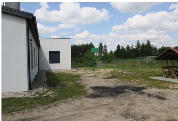
Fot. XIIB. Widok na boiska. Źródło: opracowanie własne.
