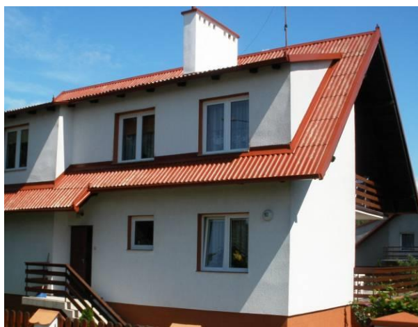
Rys. 5. Przykład zabezpieczenia wykonanego powłoką malarską.
