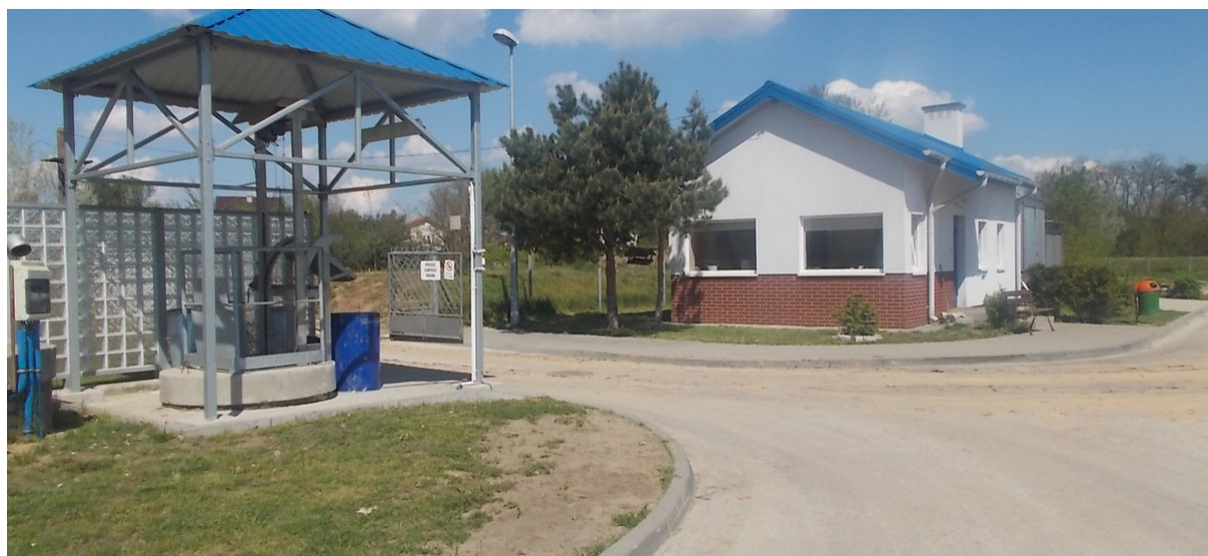
Rysunek 2. Oczyszczalnia ścieków „MEWA” w miejscowości Pomiechówek.
