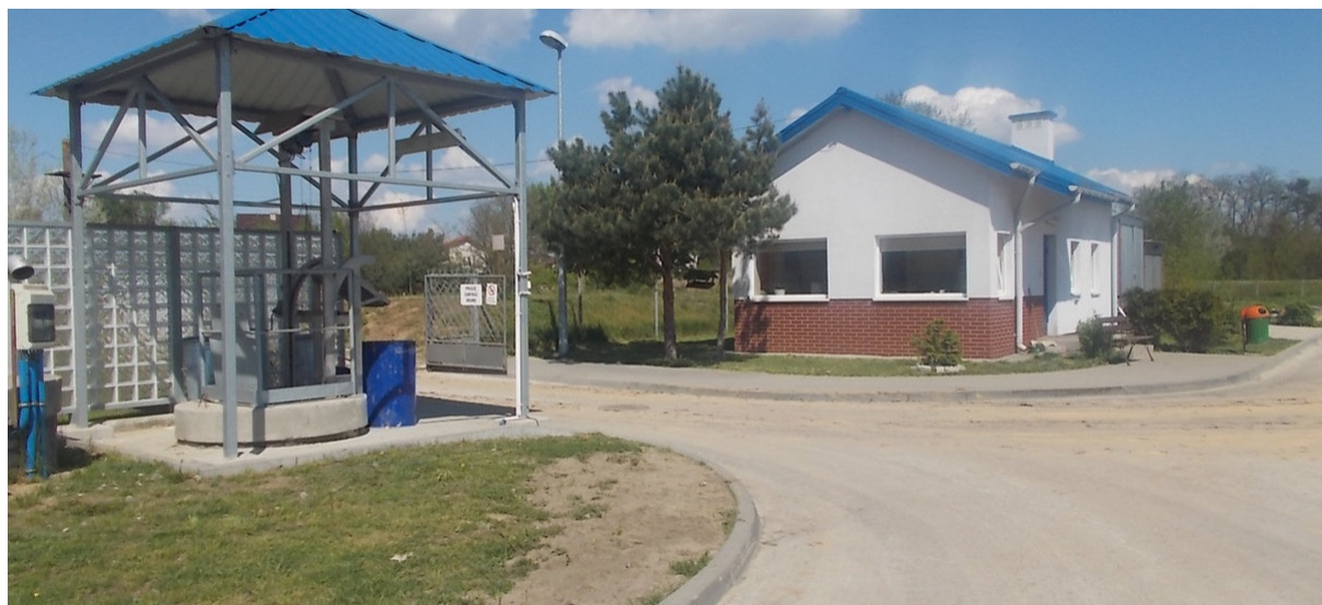
Rysunek 2. Oczyszczalnia ścieków „MEWA” w miejscowości Pomiechówek. Źródło: http://www.kzb.pomiechówek.pl/
