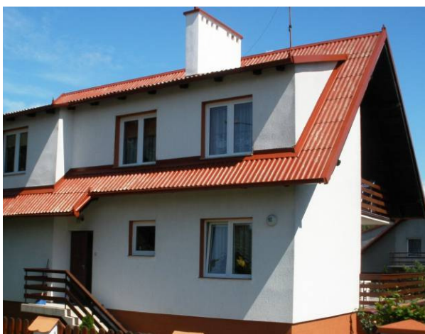
Rys. 5. Przykład zabezpieczenia wykonanego powłoką malarską.
